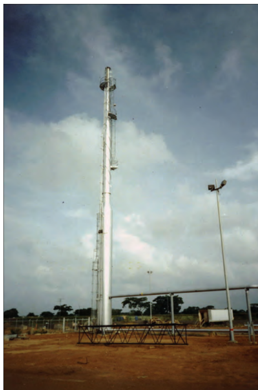
Отдельно стоящая факельная система кольца пламени
