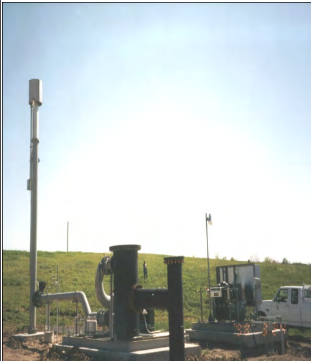
Полузакрытый факел-подсвечник для свалки
